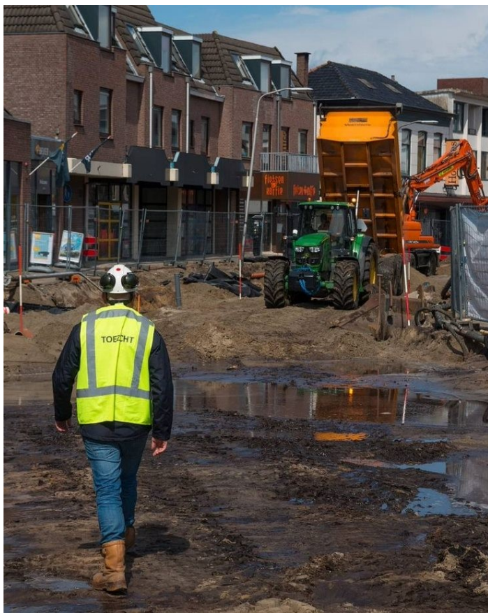
Bron: RUD Drenthe, toezichthouder aan het werk
