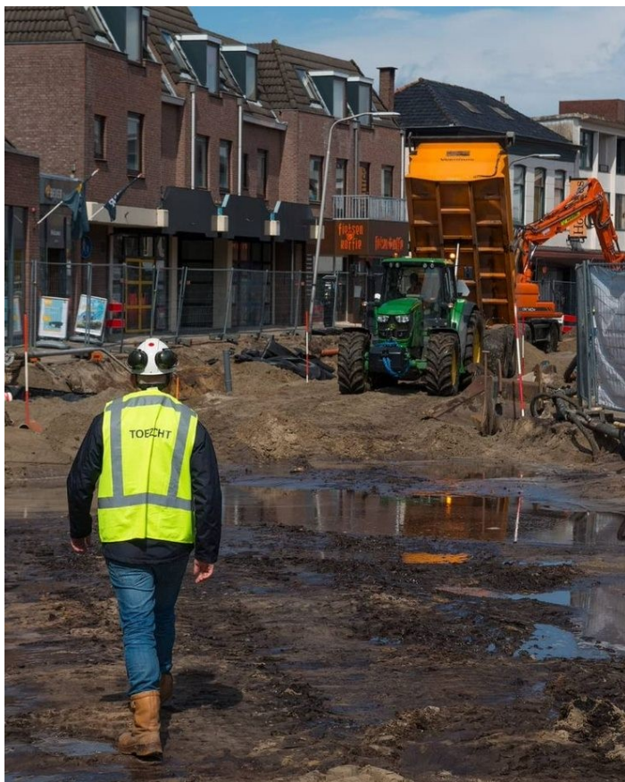
Bron: RUD Drenthe, toezichthouder aan het werk
